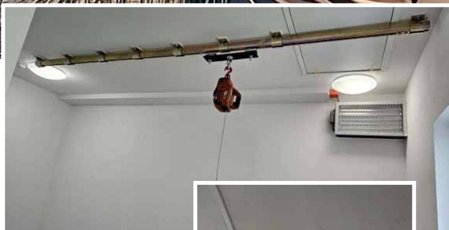
Realizace: Interia Znojmo s.r.o. Objekt: FIALA Josko Partner s.r.o
