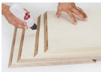
2. Nanesení lepidla do drážek
